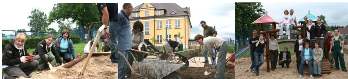
Fot. pracownicy BGK podczas budowy placu zabaw (26 czerwca 2009r.)
